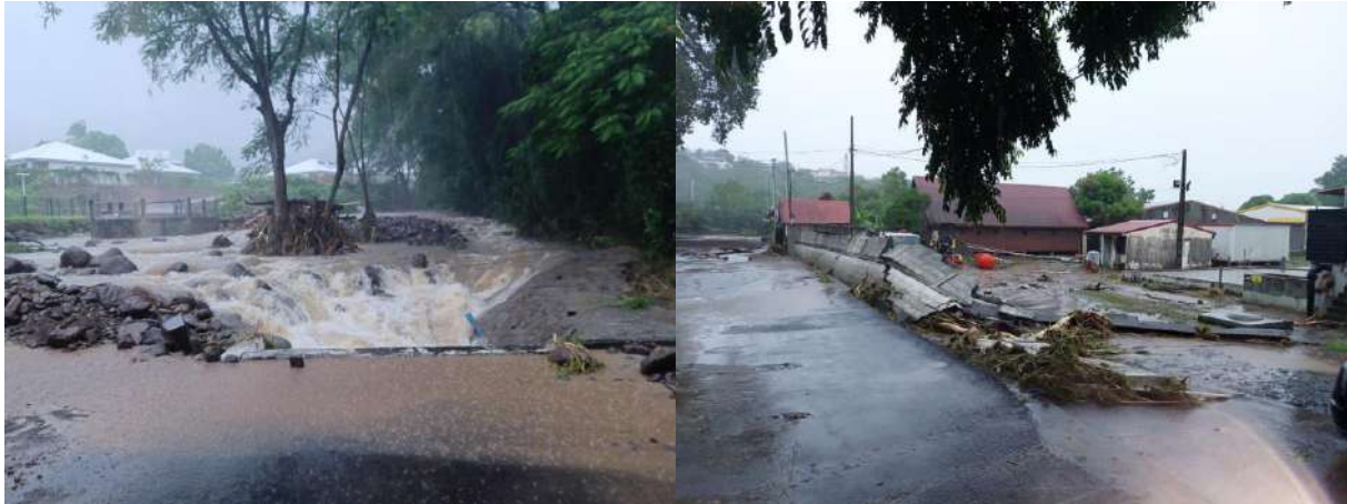
Poste de relevage envahi par les eaux de la ravine sortie de son lit.
