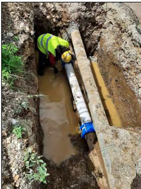
Réparation casse refoulement PR Blachon DN 200 amiante ciment
