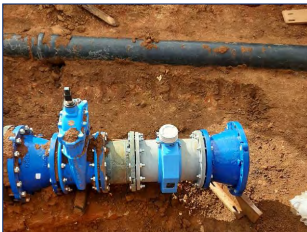
Photo : Raccordement du débitmètre d'entrée STEP Blachon II – Décembre 2021
