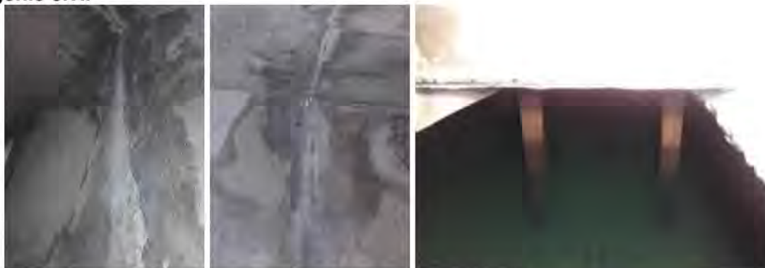
Photo 7: génie civil au réservoir de Borromée
