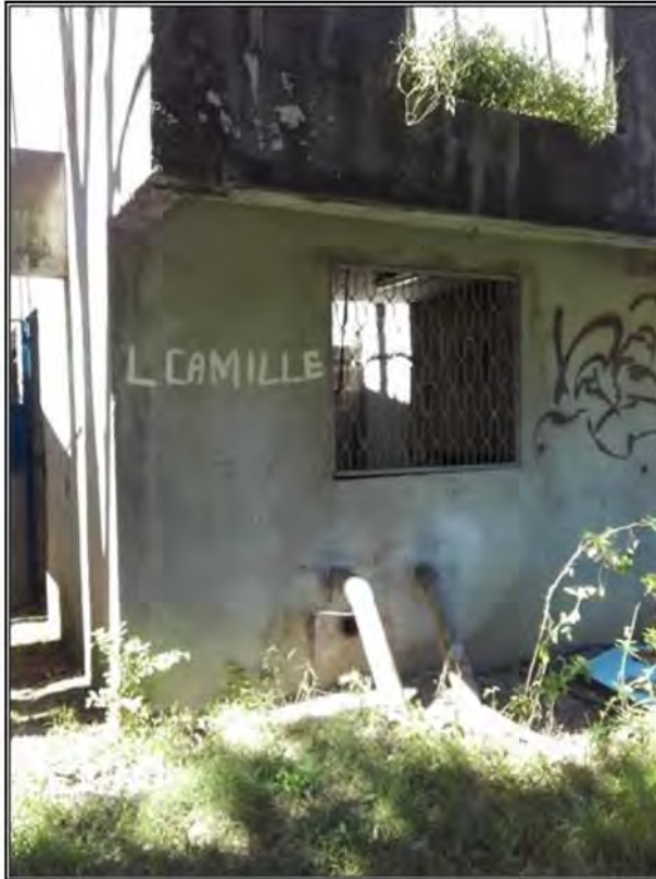
Photo 6: pompage de Z.A les Plaines
